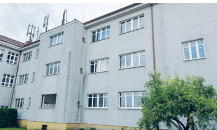
Výměny oken se dočkala severní část budovy.
